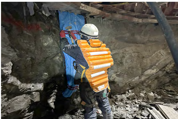
換気立坑坑底(396.0m) 裏面排水材設置作業 (令和6年4月8日撮影)
