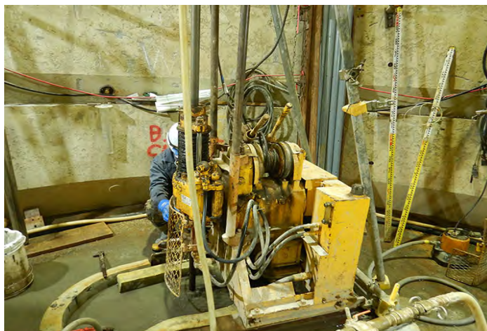
西立坑坑底(365.0m) 湧水抑制対策のボーリング作業 (令和6年4月17日撮影)
